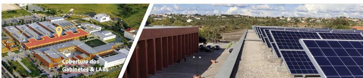
Figura 3-8. Equipamento solar-fotovoltaico para produção de energia elétrica
