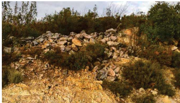
Collapsed Wall from the Bronze age Castelo Velho da Zimbreira, Mação
